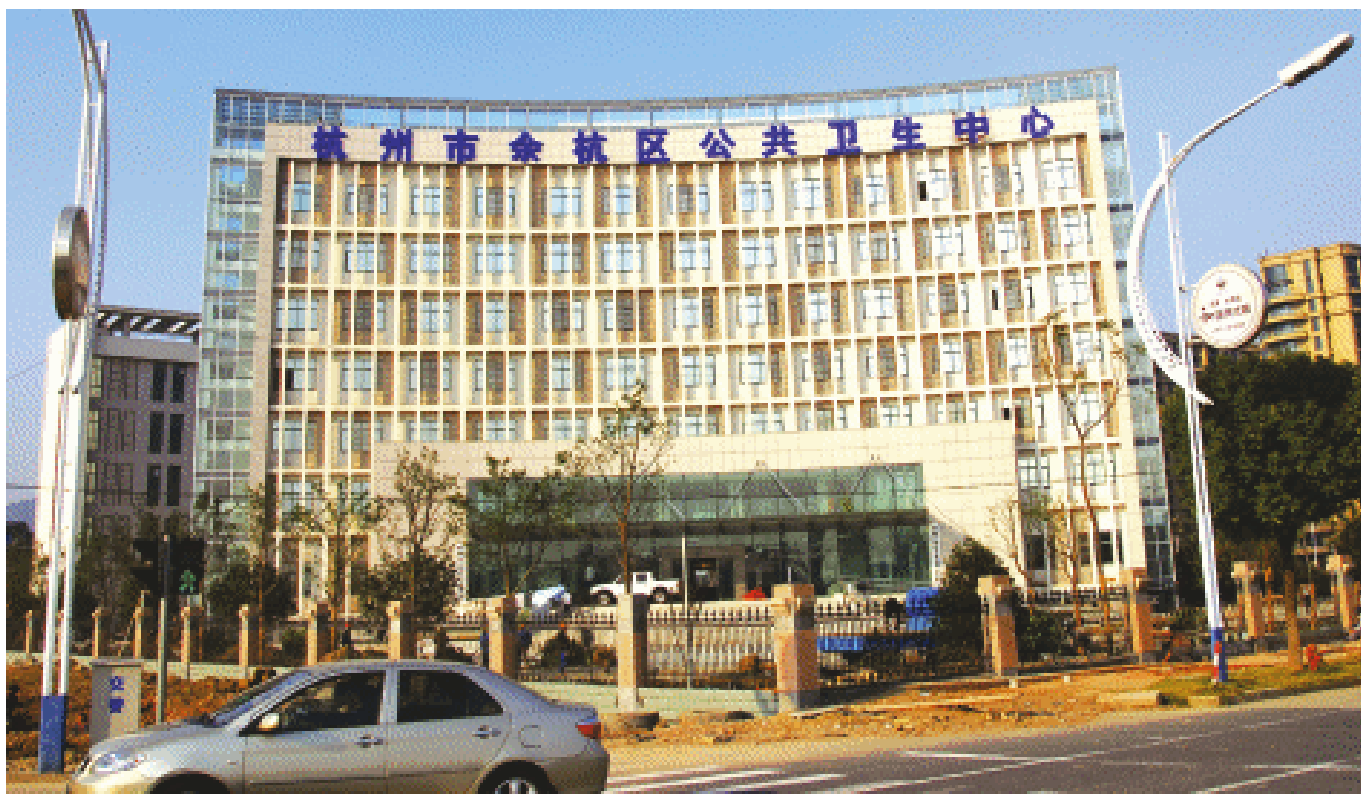
余杭区公共卫生中心大楼
