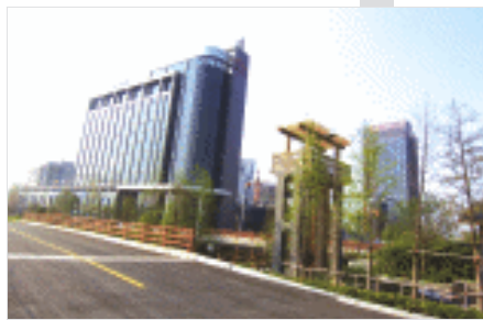
迎体路二期工程
