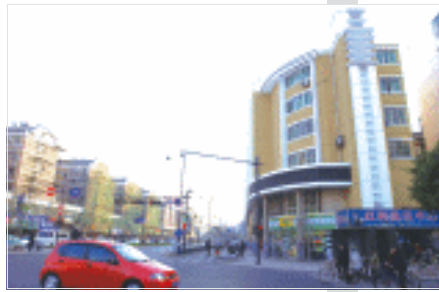
东湖路二期立面整治工程
